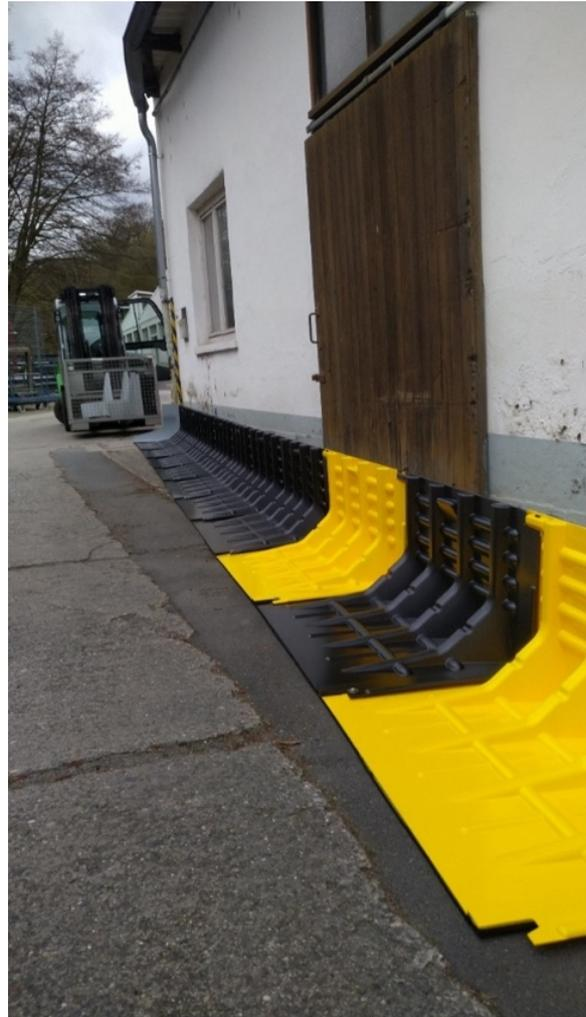
Abbildung 14: Installierter Hochwasserschutz am Standort Lorch
